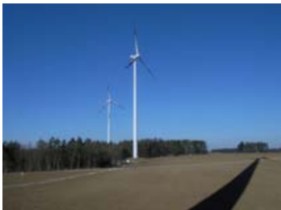
Abb. 33: Windpark mit Turmschatten.
