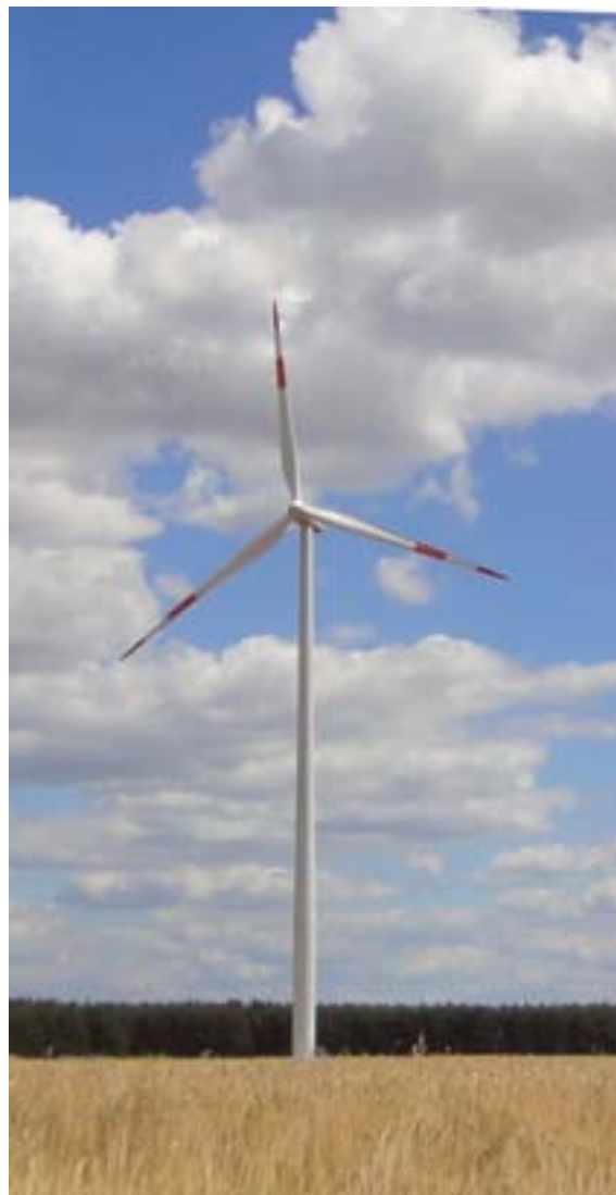
Abb. 13: Windkraftanlage der 2 MW Klasse.
